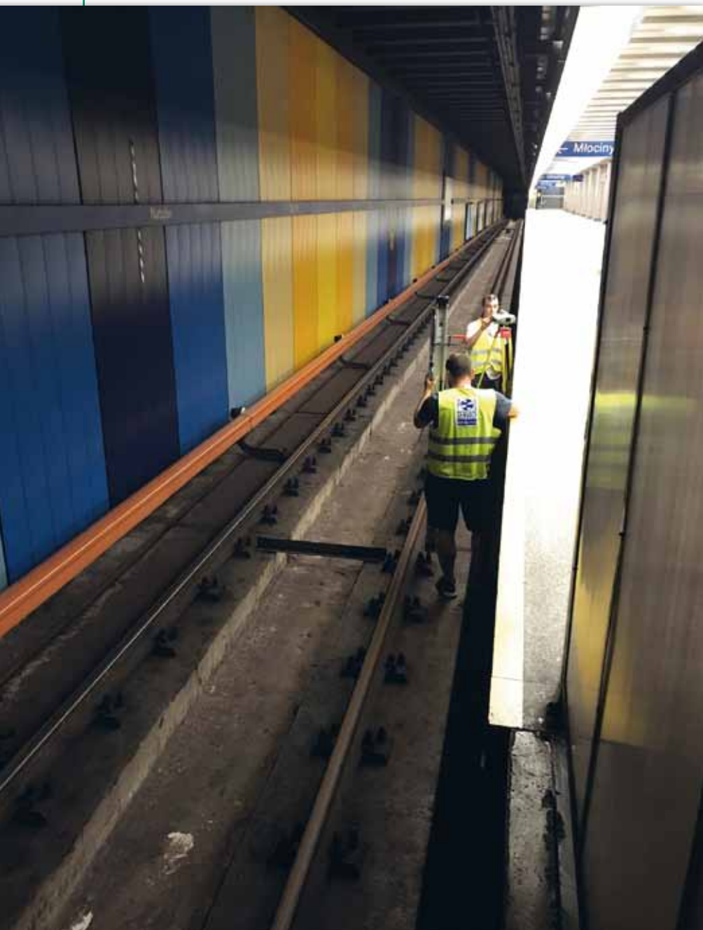
Pomiar niwelacyjny w ramach monitoringu I linii metra biegnącej nad tunelem POW
