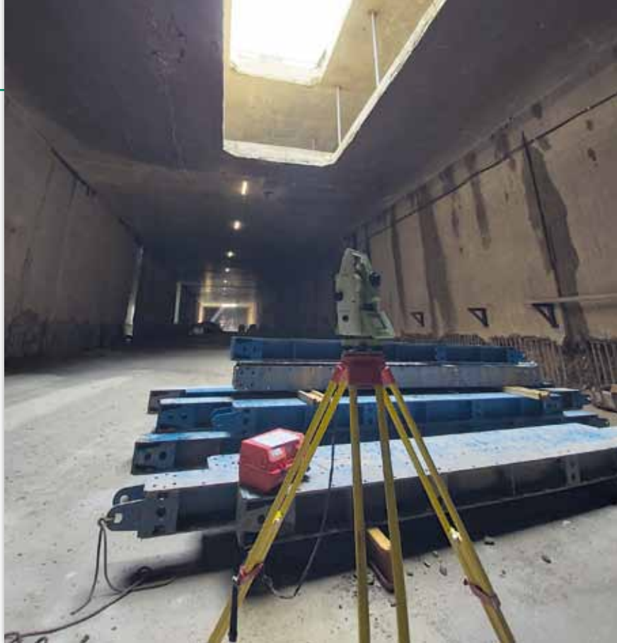
Prace w tunelu POW budowanym metodą podstropową
